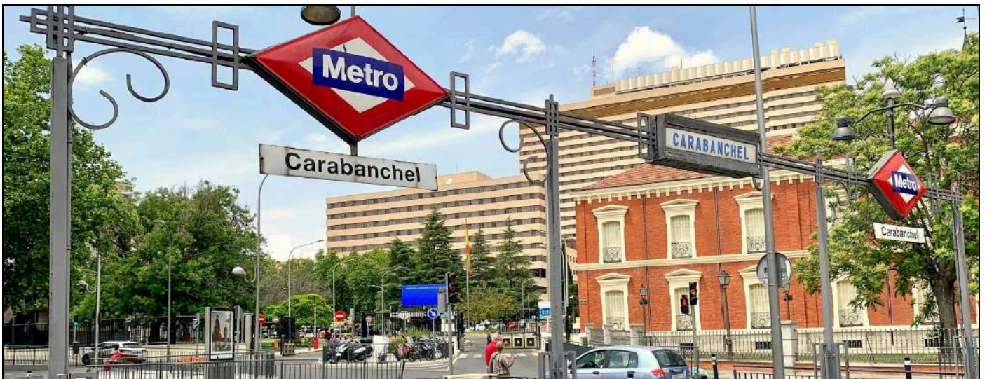
FOTOS DE AYER Y HOY DE LA ENTRADA DE LA ESTACIÓN DE METRO DE CARABANCHEL. FOTOS: EDITORIAL ARTELIBRO Y ARCHIVO JMD
